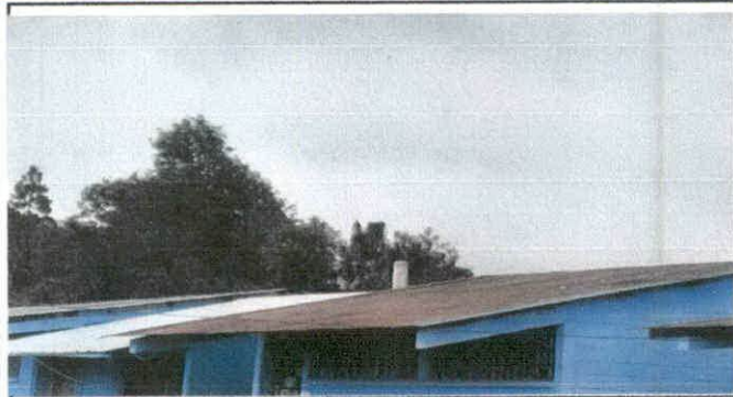
Fot. 1 Sustitución de lámina por lámina troquelada aluzin Cal. 26
