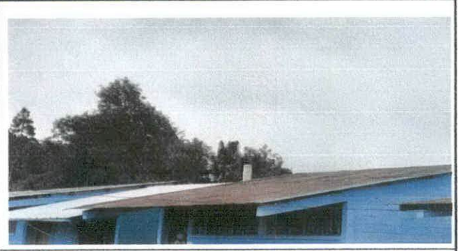
Fot. Sustitución de capote de lámina para lamina troquelada.
