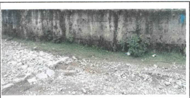
Fot. 6 Reparación de torta de cemento en el patio
